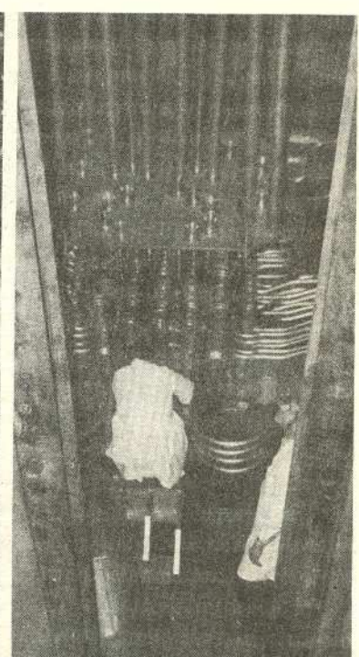
Widok „zimnego” i „niezatopionego” rdzenia reaktora Maria przez służę z komory do przeładunku pretów paliwowych
